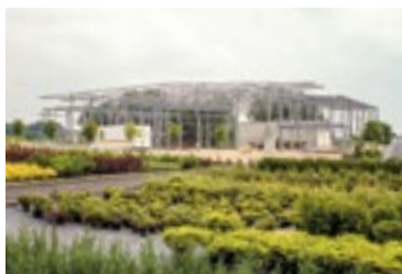
Hala produkcyjna w trakcie budowy. 2003 Production hall in the course of construction. 2003
