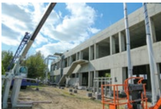
Budowa biura trwała prawie 4 lata – na zdjęciu montaż stalowej konstrukcji tarasu. 2014 Construction of the office building took 4 years – the picture presents assembly of the terrace steel structure, 2014
