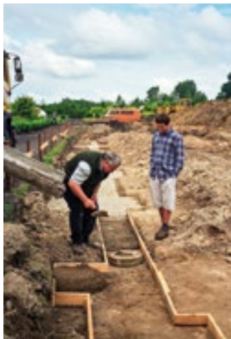
Bronisław Szmit z synem Bronisławem Janem – wmurowywanie kamienia węgielnego pod budowę hali. 2003 Bronisław Szmit with his son Bronisław Jan – the laying of the foundation stone for the new hall. 2003
